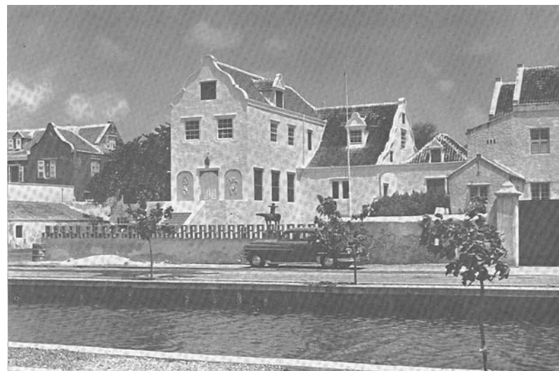
Foto 06. Stroomzigt na gedeeltelijke demping van het Rifwater
