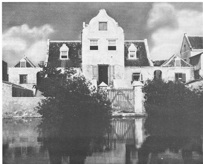
Foto 04. Stroomzigt aan het voormalig Rifwater
