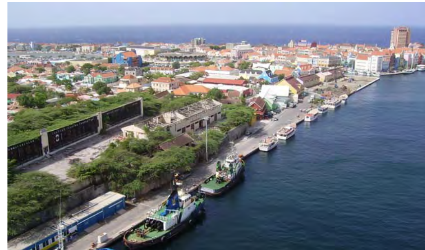
Foto 09. Zicht op de kades en de loodsen
